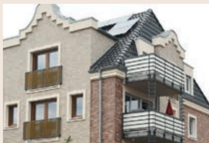
Neue Fassade am Obst-Quartier Raiffeisenstraße in Hamminklen
