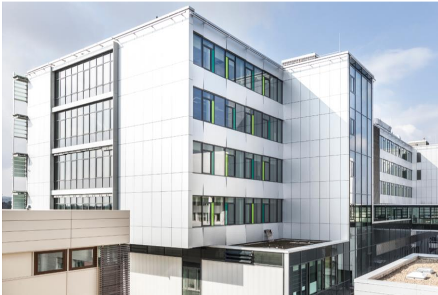
Neubau Technikum Gebäude D in Stuttgart
